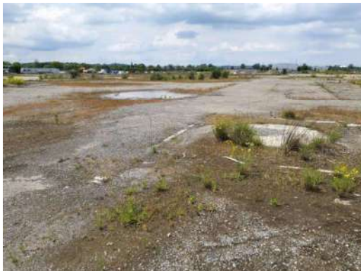
Ancienne plateforme goudronnée
