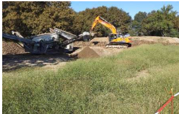
Zone en travaux (inaccessible)
