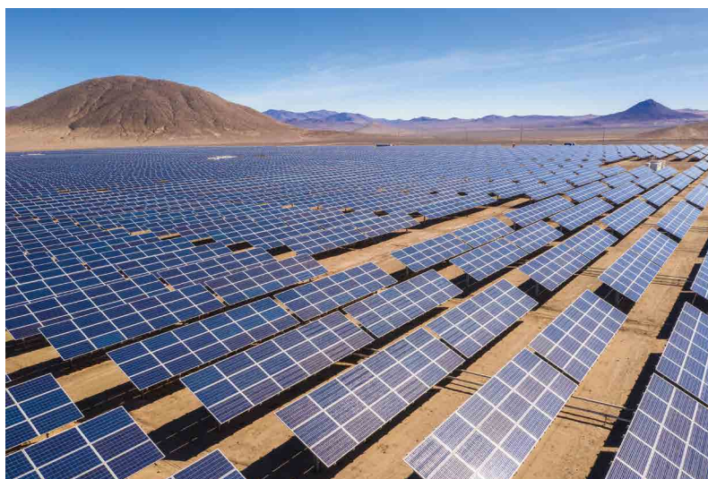
Centrale solaire dans le désert d'Atacama au Chili Bolero SolarChile, 2016
